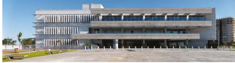
16. Giriş cephesinde brüt beton kırışların vurgulanması ile sağlanan tektonik algı
